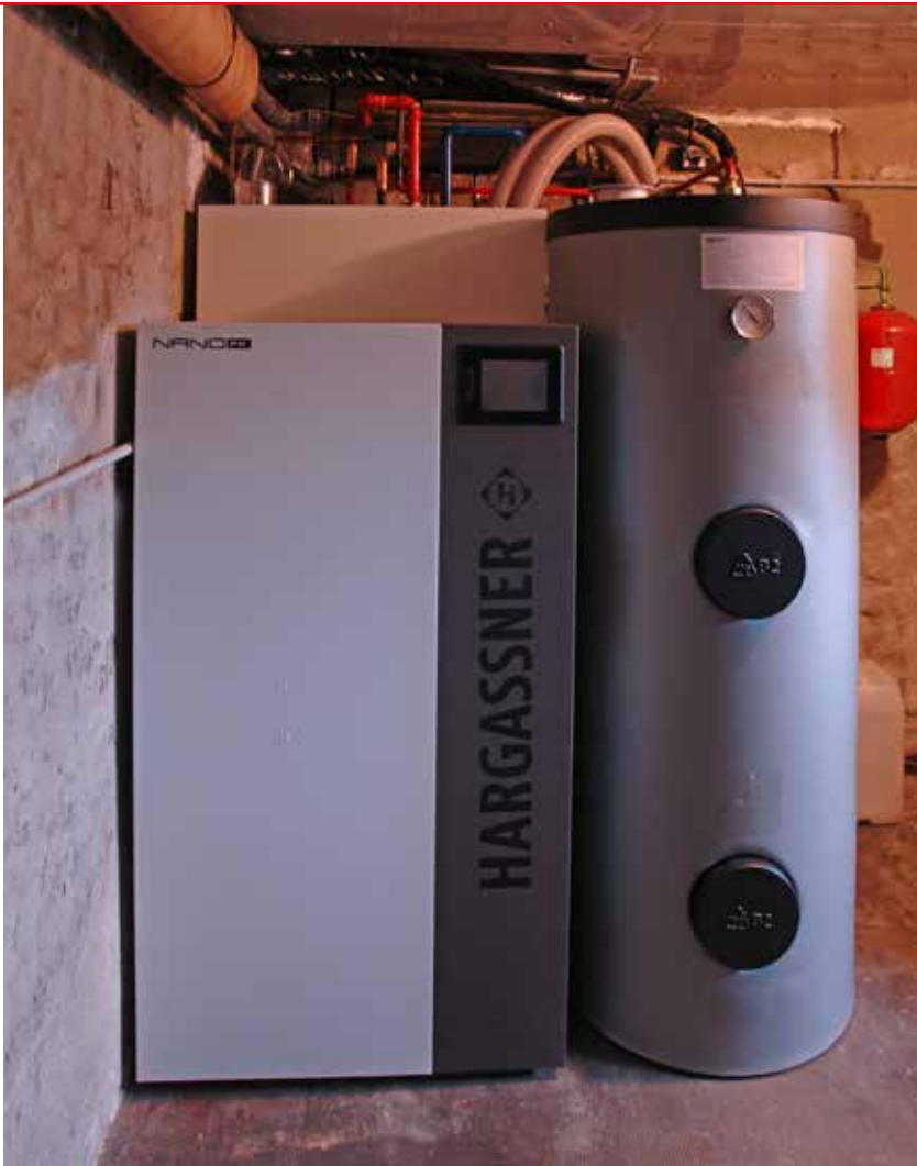
La chaudière nanoPK est suffisamment compacte ( 80 x 60 cm) pour trouver place au sous-sol, avec le ballon tampon (solaire et granulés) juste à côté du silo. Ce dernier, fabriqué en OSB par ID Energies Bio, dispose du volume nécessaire pour une année de chauffe. Ci-contre, une fenêtre permet de contrôler le niveau de granulés dans le silo.
