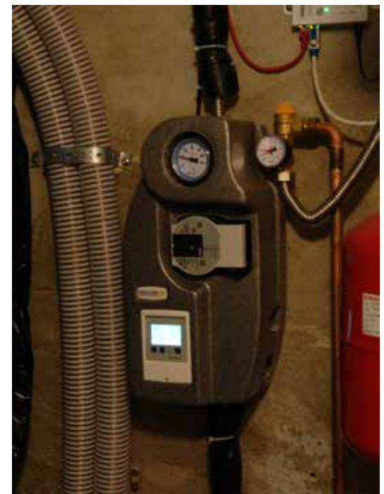
Module de régulation du ballon tampon solaire.
